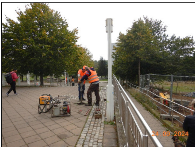
Abb.2-4: Durchführung der Kleinrammbohrungen (KRB) 1 bis 3
